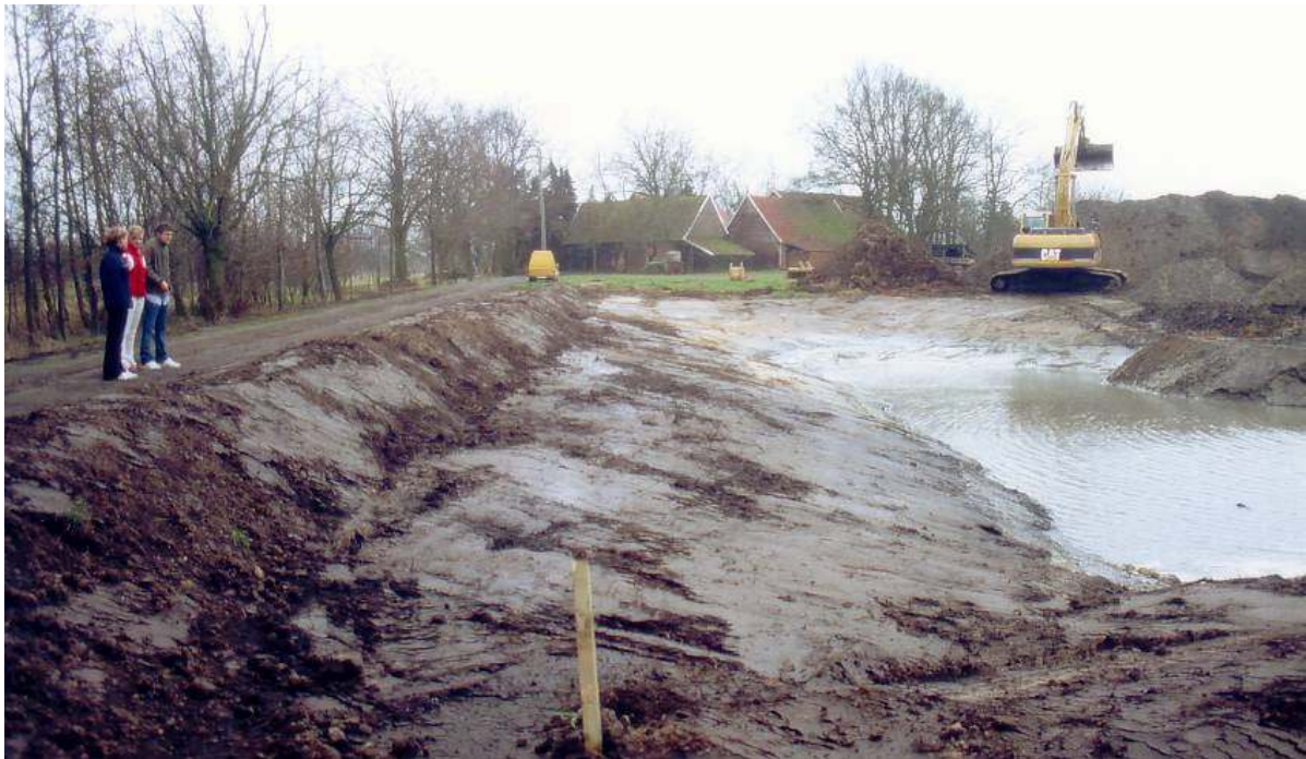
Schüler der Naturkunde-AG verfolgen im Februar 2004 die Anlage eines neuen Teiches im Freilandlabor Wasserhausen.
