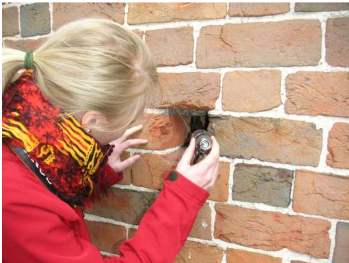
Fledermaus im Mauerwerk der Stiftskirche Börstel
